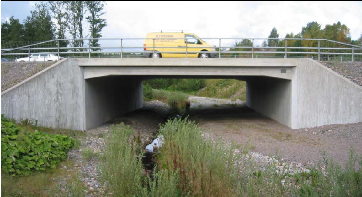
Figur 7. En viltanpassad undergång (Viltport vid Rom, E6 vid Dingle) designad för rådjur och mindre vilt. Måtten på passagen är 11,5 x 3,1 x 21,1 m (Bredd x höjd x längd). Denna passage är troligtvis för låg för att användas av vildsvin, som enligt Olbricht (1984) kräver en minsta höjd av 4 meter. Foto: Mattias Olsson
