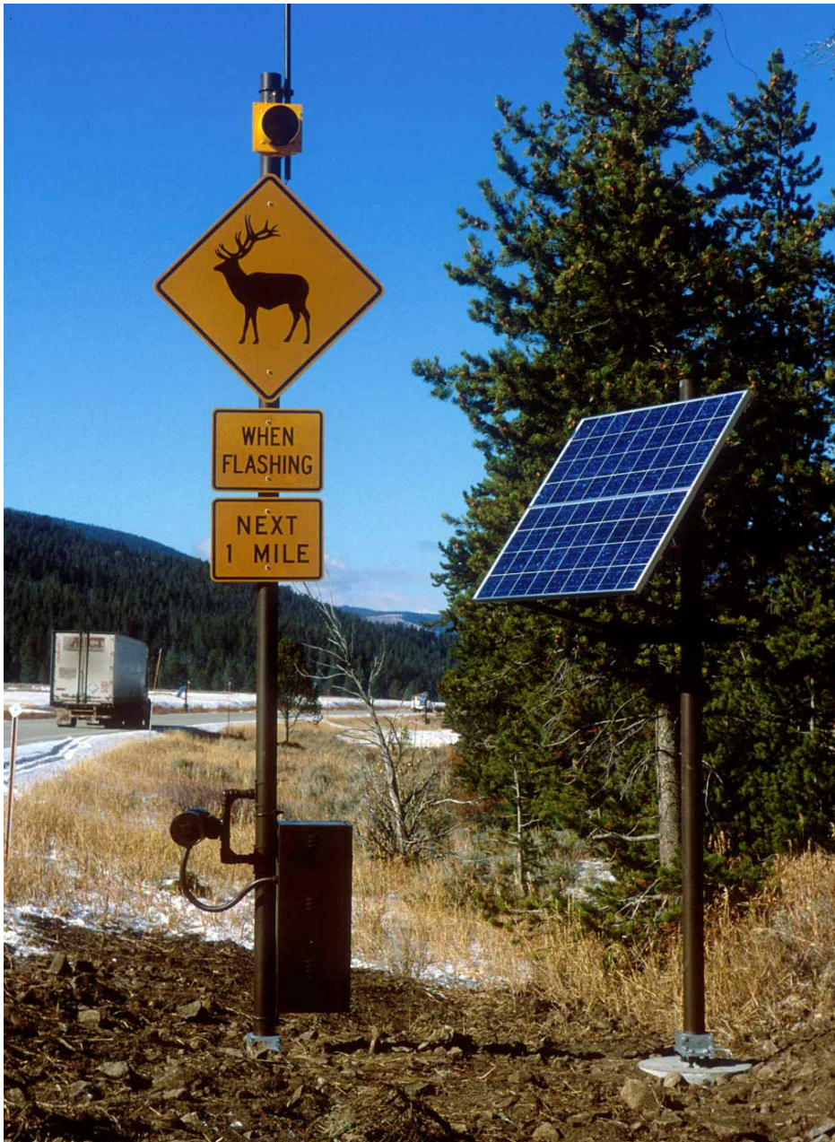
Figur 8. Denna typ av viltvarningssystem används längs US Highway 191 i Montana och drivs med solenergi. Systemet med detektorer som aktiverar varningssystemet när djur rör sig i omedelbar närhet till vägen sträcker sig ca 1,6 km. Foto: Marcel Huijser/WTI-MSU.
